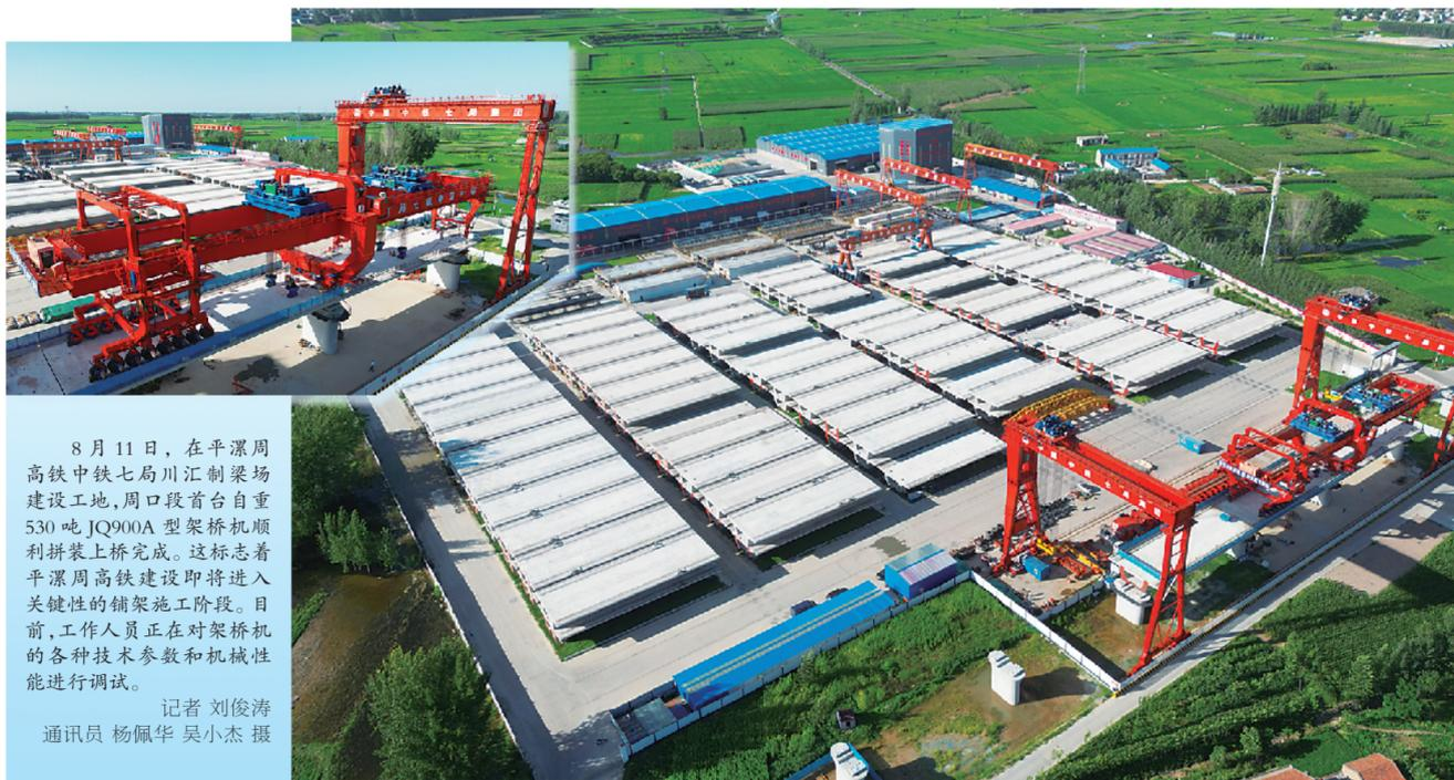
8月11日,在平深周高铁中七局川汇制梁场建设工地,周口段首台自重530吨JQ900A型架桥机顺利拼装上桥完成。这标志着平深周高铁建设即将进入关键性的铺架施工阶段。目前,工作人员正在对架桥机的各种技术参数和机械性能进行调试。
